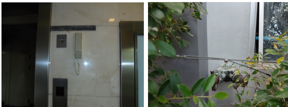
ภาพที่ 4-19 บั้ยทางออกฉุกเฉิน บันไดหนีไฟ และ โทรศัพท์ฉุกเฉินหน้าลิฟต์ หัวรับน้ำดับเพลิงจากภายนอก
