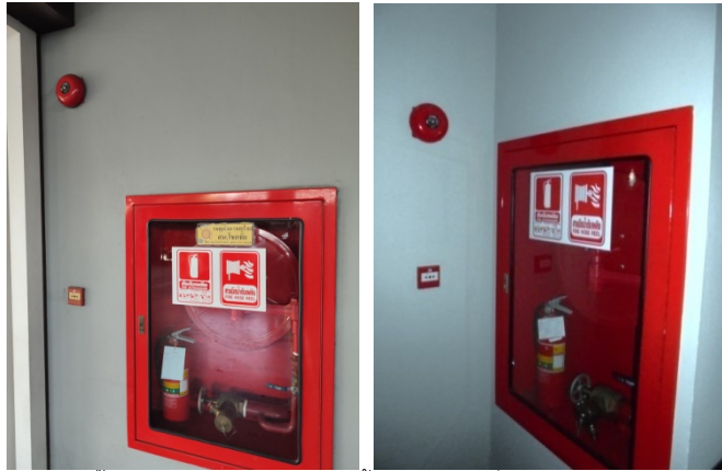
ภาพที่ 4-17 ตู้เก็บสายฉีดน้ำดับเพลิงพร้อมอุปกรณ์ติดตั้งไว้ใกล้กับ กริ่งสัญญาณดับเพลิงและ Manual Station
