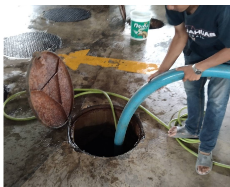
ภาพที่ 4-33 ดูตะกอนบ่อเกรอะและบ่อพักตะกอนที่ระบบบำบัดน้ำเสีย
